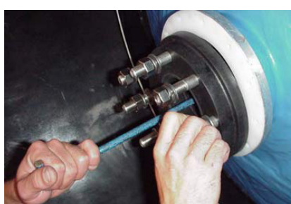
5.Schritt: Flansch adapter auf Montage schrauben, dabei beachten dass der Dichtungsring auf dem Adapter montiert ist und abschliesst
