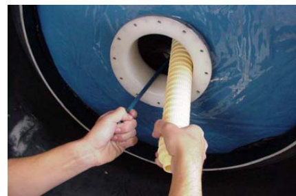
3.Schritt: Montierte Einzelteile müssen komplett im Behälter sein, um das Verteilerrohr zu montieren
