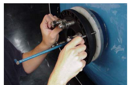
6.Schritt: Zur Montage des Verteilersystems auf den Flansch den hinteren Flansch verwenden. Montagehilfe entfernen
