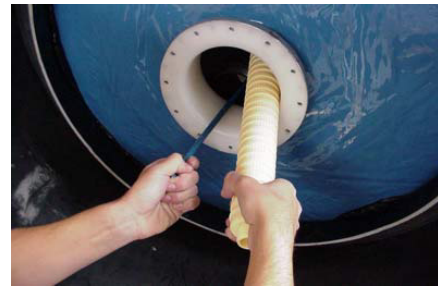
3.Schritt: Montierte Einzelteile müssen komplett im Behälter sein, um das Verteilerrohr zu montieren
