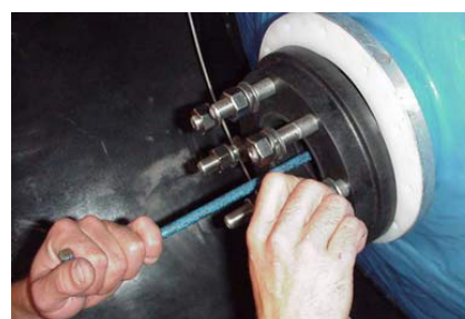
5.Schritt: Flansch adapter auf Montage schrauben, dabei beachten dass der Dichtungsring auf dem Adapter montiert ist und abschliesst
