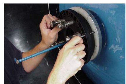
Paso 6: Utilice la contrabrida para conectar el sistema de distribución a una brida de 6". Ahora proceda a retirar la extensión.
