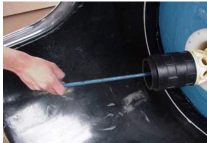
Paso 2: Las piezas mostradas en el Paso 1 se montan (fuera del depósito) y se introducen en este mediante la extensión I-WR03-LA.
