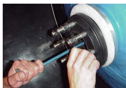
Paso 5: Atornille el adaptador de brida al conjunto. Asegúrese de que la junta tórica esté correctamente fijada y sellada al adaptador.
