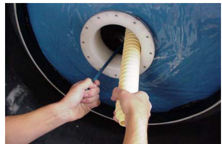
Fase 3: Mettere il gruppo all'interno del serbatoio per montare i laterali.
