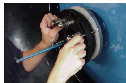
Fase 6: Utilizzare la flangia di appoggio per collegare il sistema di distribuzione alla flangia 6". Adesso rimuovere l'estensione.
