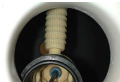
Fase 4: Avitare tutti laterali nel mozzo continuando a tenere l'estensione.
