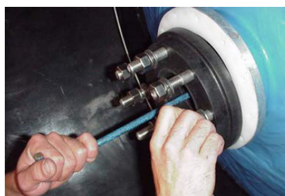
Fase 5: Avitare l'adattatore flangia sul gruppo. Assicurarsi che l'O-ring sia collegato all'adattatore e sigillato adeguatamente.
