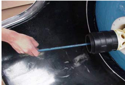
Stap 2: De onderdelen uit stap 1 zijn gemonteerd (buiten de tank) en met extensie I-WR03-LA in de tank ingebracht.
