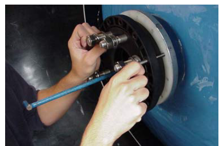
Stap 6: Gebruik de flens om het verdeelsysteem op de 6" flens aan te sluiten. Neem nu de extensie weg.
